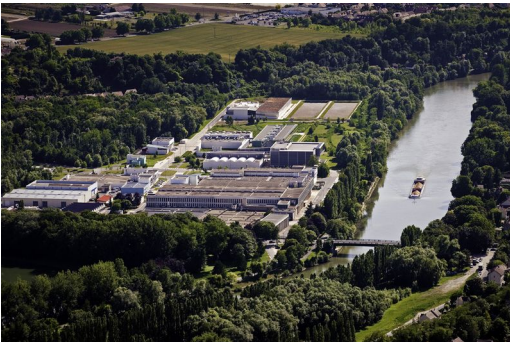
station de fabrication d'eau potable de Méry sur Oise
